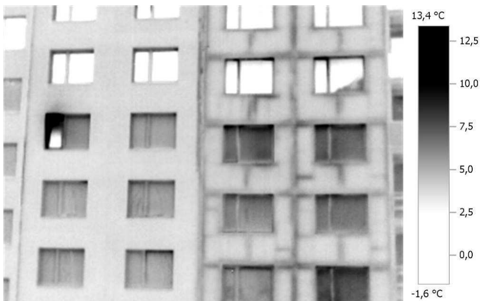
Obrázek 1.: Termogram zateplené a nezateplené části panelového domu. Levá část je zateplená – má menší povrchovou teplotu. Čím vyšší je teplota povrchu tím tmavší je barva.
