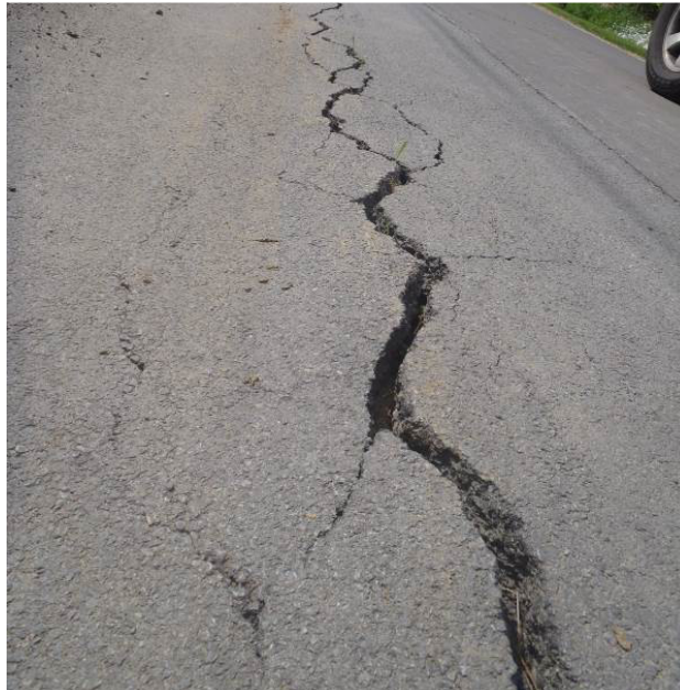
Obrázok 2. Príklad pozdĺžnej trhliny v kryte
