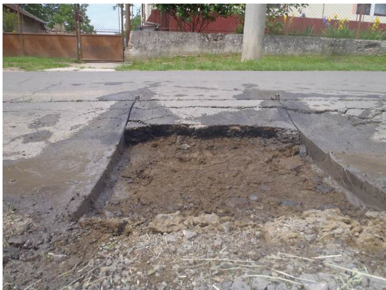
Obrázok 6 .Príklad podkladovej vrstvy vozovky pod vyrezaným krytom
