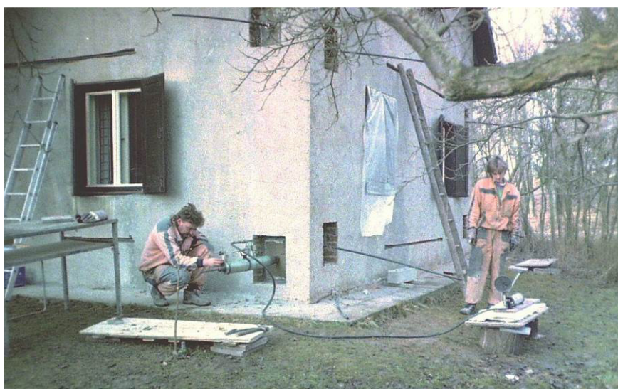
Obrázek 3.: Předpínání, vlevo čelní fasáda, vpravo štít
