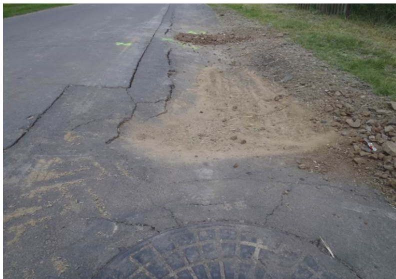
Obrázok 3. Príklad veľkého poklesu vplyvom zlých konštrukčných vrstiev pod krytom
