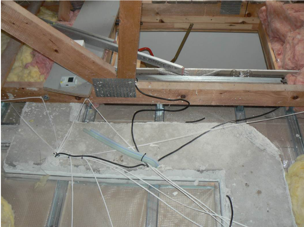
Obrázek 4.: Dobře patrná skutečná poloha středního vazníku konstrukce, kdy je vazník umístěn zcela mimo příčnou část střední nosné zdi.
